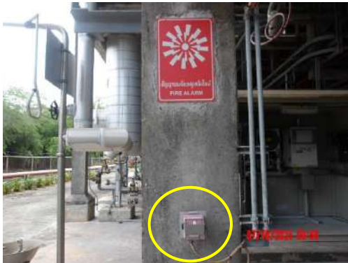
รูปที่ 2-40 ปุ่มกดแจ้งเหตุฉุกเฉิน (Manual Call Point) บริเวณรอบหน่วยผลิตใหม่
