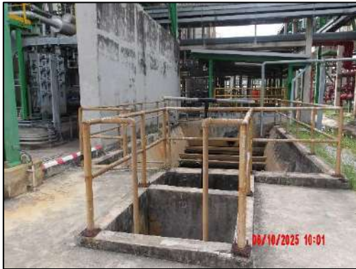
รูปที่ 2-6 บ่อตกตะกอน/บ่อพักน้ำ
