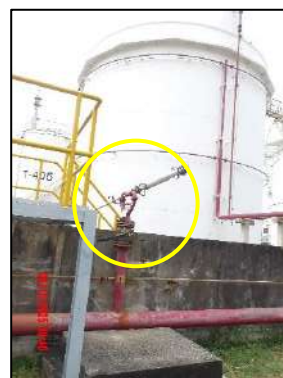
รูปที่ 2-59 Foam Monitor และ Water Monitor บริเวณลานถังเก็บสำรอง
