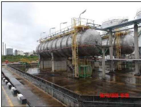
รูปที่ 2-36 พื้นลานถังที่เป็นคอนกรีตเสริมเหล็ก
