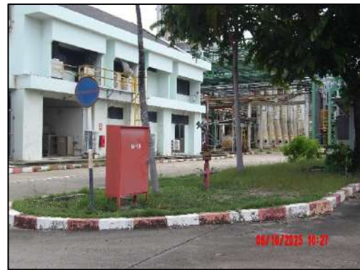
รูปที่ 2-67 Hydrant พร้อมตู้อุปกรณ์ส่งน้ำดับเพลิง บริเวณสถานีสูบน้ำ
