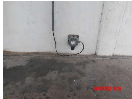
รูปที่ 2-47 ระบบตรวจจับเพลิงไหม้ชนิด UV และ Gas Detector
