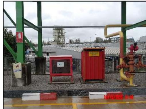
รูปที่ 2-65 หัวฉีดสายดับเพลิง (Hydrant) และระบบดับเพลิงแบบใช้โฟมและน้ำ
