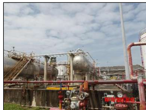
รูปที่ 2-57 ระบบฉีดน้ำ (Water Sprinkler) บริเวณถังเก็บ
