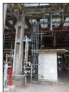
รูปที่ 2-45 ระบบดับเพลิง (Water Deluge System) แบบสเปรย์น้ำภายในผ้า
