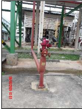
รูปที่ 2-46 ปืนฉีดน้ำดับเพลิง (Water Monitor)
