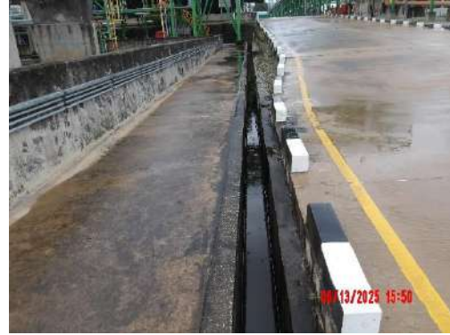
รูปที่ 2-35 รางระบายน้ำล้อมรอบพื้นที่ลานถัง
