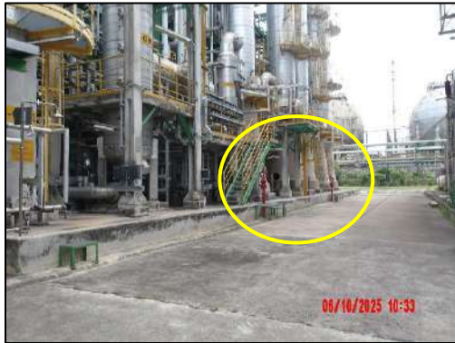
รูปที่ 2-52 หัวฉีด/โฟม (Fixed Water/Foam Monitor) ในพื้นที่หน่วยผลิตใหม่
