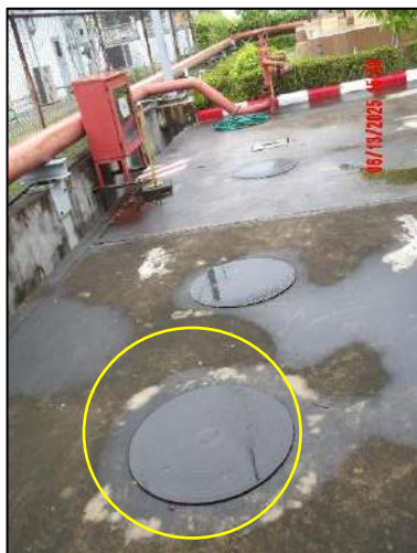
รูปที่ 2-3 ถังบำบัดน้ำเสียสำเร็จรูป
