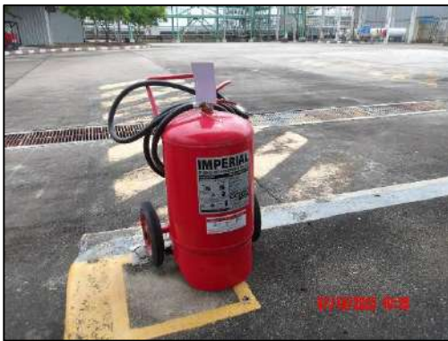
รูปที่ 2-66 เครื่องดับเพลิงชนิดผงเคมีแห้งแบบที่ สามารถเคลื่อนย้ายได้ บริเวณสถานีสูบน้ำ
