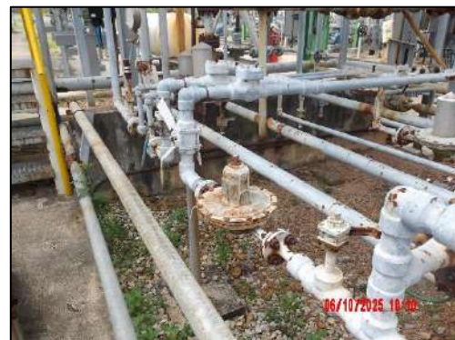
รูปที่ 2-43 ติดตั้งระบบรักษาความดัน ภายในถังเก็บ
