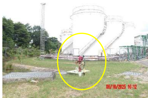
รูปที่ 2-63 Water fix monitor ในพื้นที่ถังเก็บผลิตภัณฑ์ C11 Plus Aromatic (T-807)
