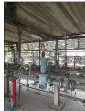
รูปที่ 2-69 อุปกรณ์ตรวจสอบการรั่วไหล เช่น Pressure Indicator บริเวณ Metering Station
