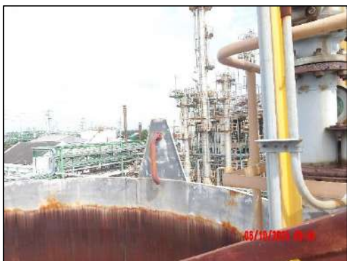
รูปที่ 2-58 ระบบโฟมไว้ที่ด้านถังเฮกเซน บริเวณพื้นที่ลานถัง 1 ถึง 4
