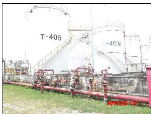
รูปที่ 2-62 Water sprinkler รอบถัง
