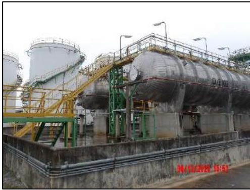
รูปที่ 2-34 คั่นกันรั้วบริเวณพื้นที่ลานถังที่เป็น คอนกรีตเสริมเหล็ก
