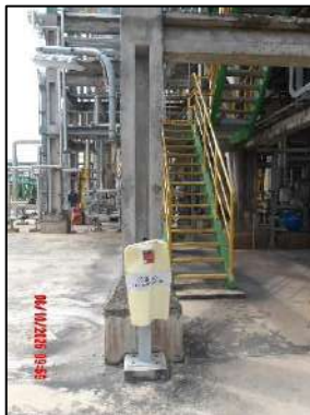
รูปที่ 2-54 ถังดับเพลิงผงเคมีแห้ง (Dry Chemical Extinguisher)
