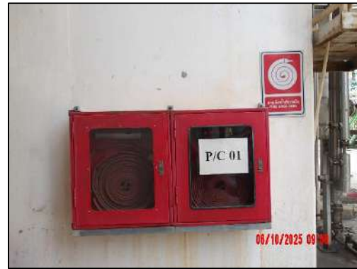
รูปที่ 2-55 ตู้เก็บอุปกรณ์ดับเพลิง (Fire Hose Box) บริเวณพื้นที่กระบวนการผลิต
