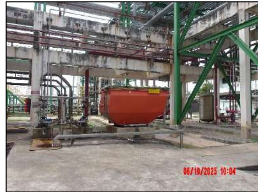
รูปที่ 2-7 ระบบบำบัดแบบ Corrugated Plate Interceptor (CPI)
