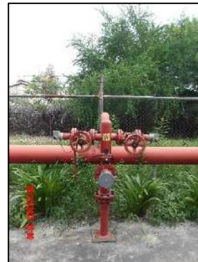
รูปที่ 2-53 หัวจ่ายน้ำดับเพลิง (Fire Hydrant) แบบสี่ทางออก พื้นที่หน่วยผลิตใหม่
