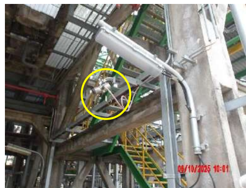
รูปที่ 2-31 ระบบตรวจจับเมื่อมีการรั่วระยะเหยของสารไวไฟ และเพลิงไหม้
