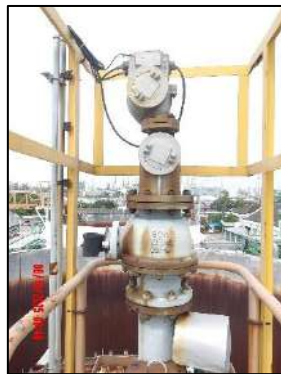
รูปที่ 2-42 Low/High Level Alarm เพื่อตรวจสอบ ระดับของสารในถังเก็บ
