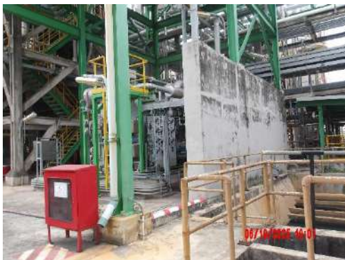
รูปที่ 2-13 กำแพงกันเสียงในพื้นที่ที่มีเสียงดัง
