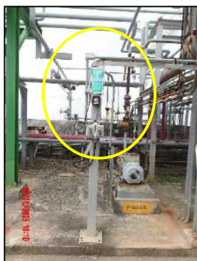
รูปที่ 2-60 Emergency Shut off Valve สำหรับถังเก็บที่เป็น Pressure Vessel
