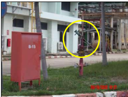
รูปที่ 2-68 Water Monitor บริเวณสถานีสูบน้ำ
