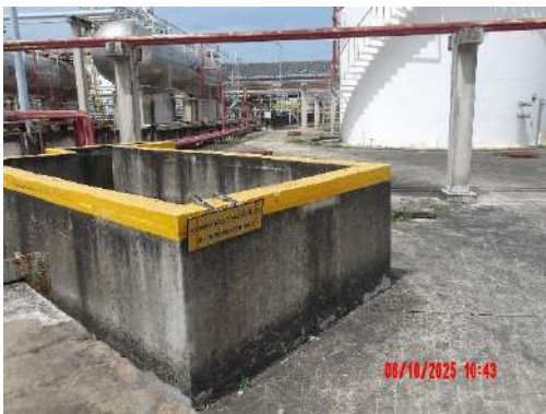
รูปที่ 2-8 ระบบบำบัดแบบ UPI Interceptor (API Interceptor)
